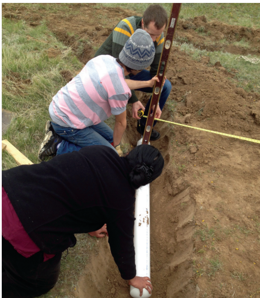
Precyzyjne ułożenie jednej z anten magnetycznych stacji
