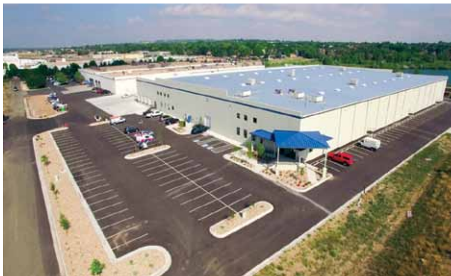
Nowy budynek firmy Wanco, Inc w Arvadzie.
