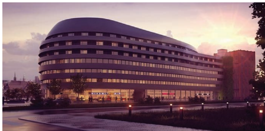
OVO Wrocław. Hotel Hilton oraz 170 luksusowych apartamentów, (cena mkw. 20 tys zł, 60% sprzedane) biura, sklepy, restauracje i kafejki. Koszt budowy całego projektu wyniósł 260 mln zł. Otwarcie hotelu ma nastąpić w 2016 roku. Będzie to pierwszy pięciogwiazdkowy Double Tree w Polsce.
